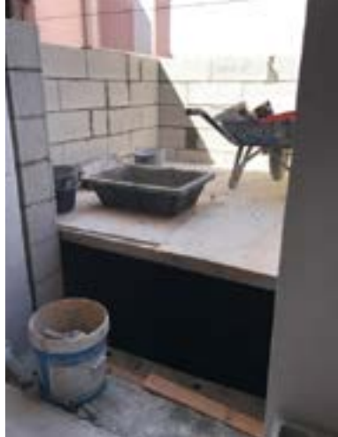
Réalisation d'un ascenseur.
