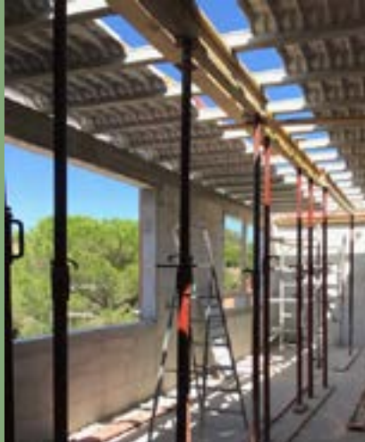
Réalisation de deux salles en lieu et place de l'ancien appartement communal.
