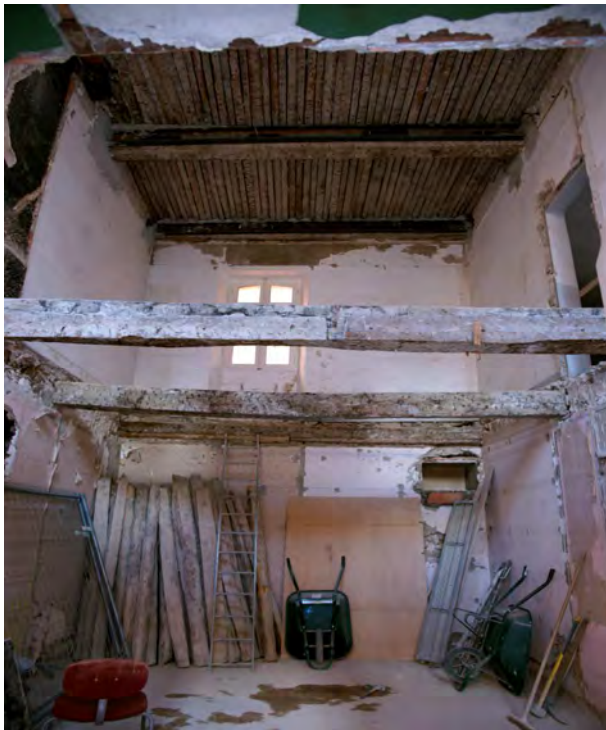
Travaux 1 rue de la Ponche
