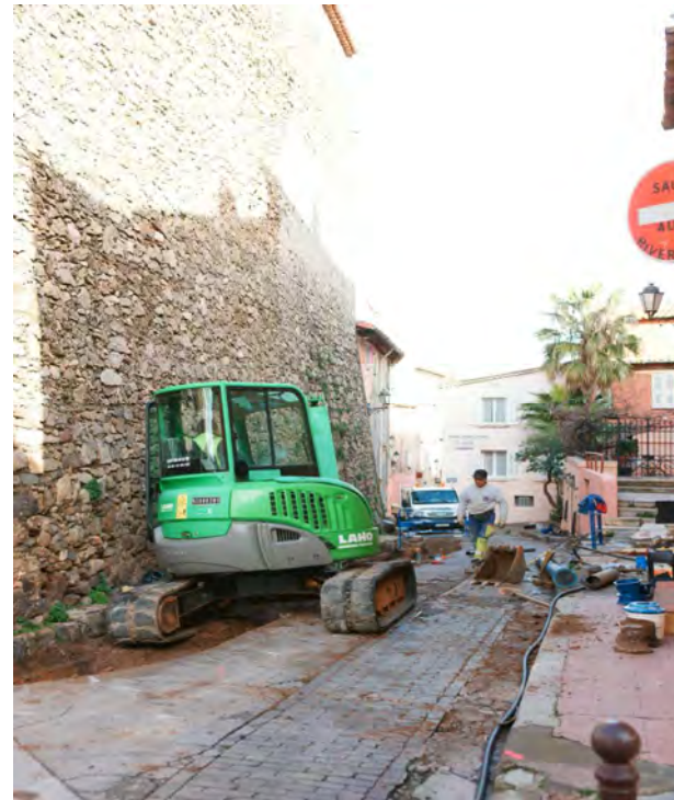
Travaux Vieille Ville
