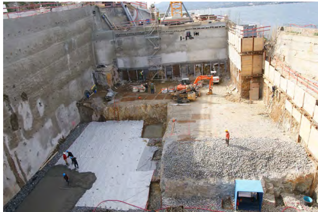
Travaux station d'épuration
