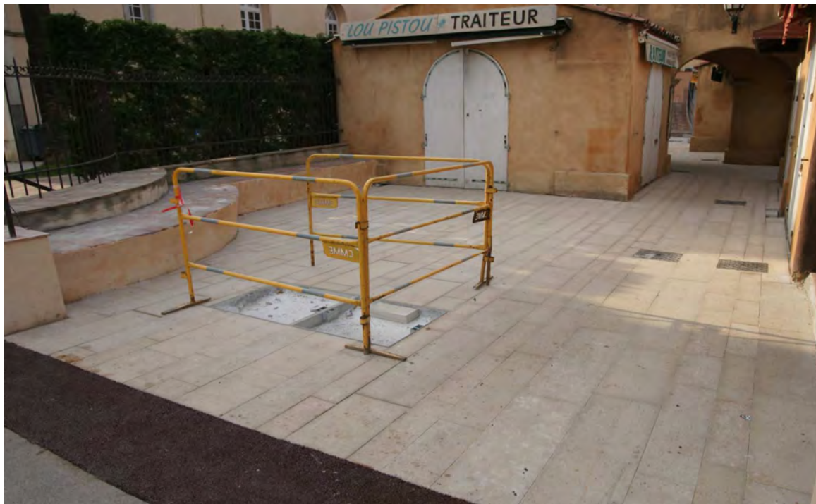
Travaux Petit Marché Boulevard Vasserot
