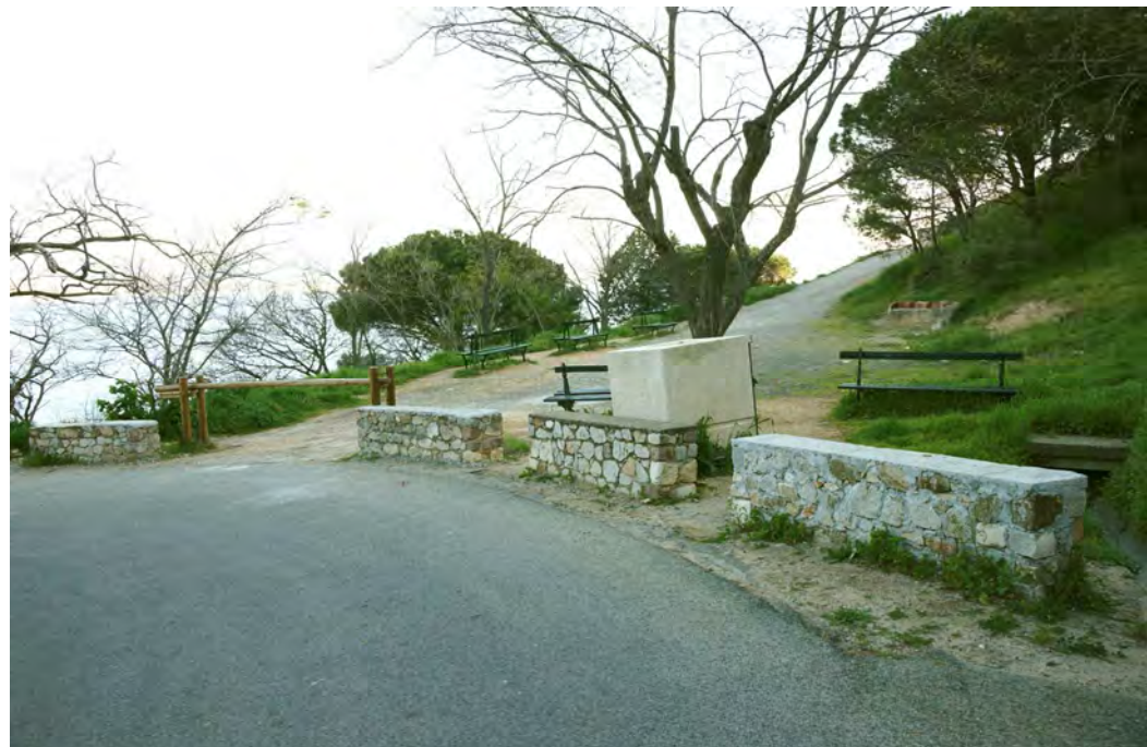
Réparation murets Esplanade « banc des Allemands »
