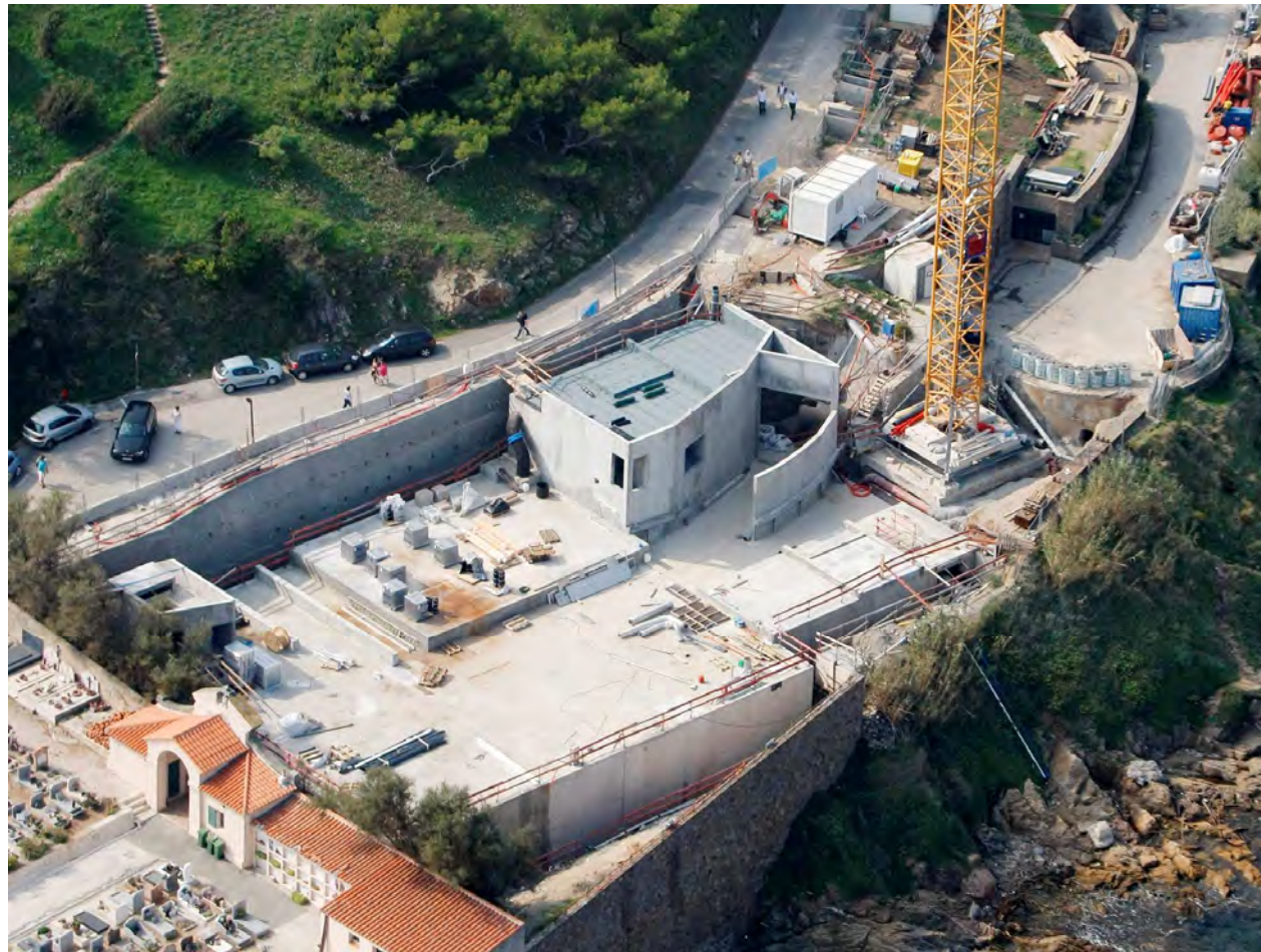
Travaux station d'épuration
