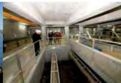
la station d'épuration
