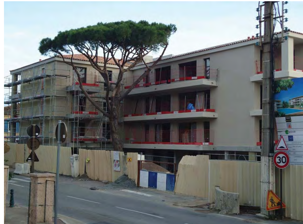
Bâtiment A Accession Av. Foch
