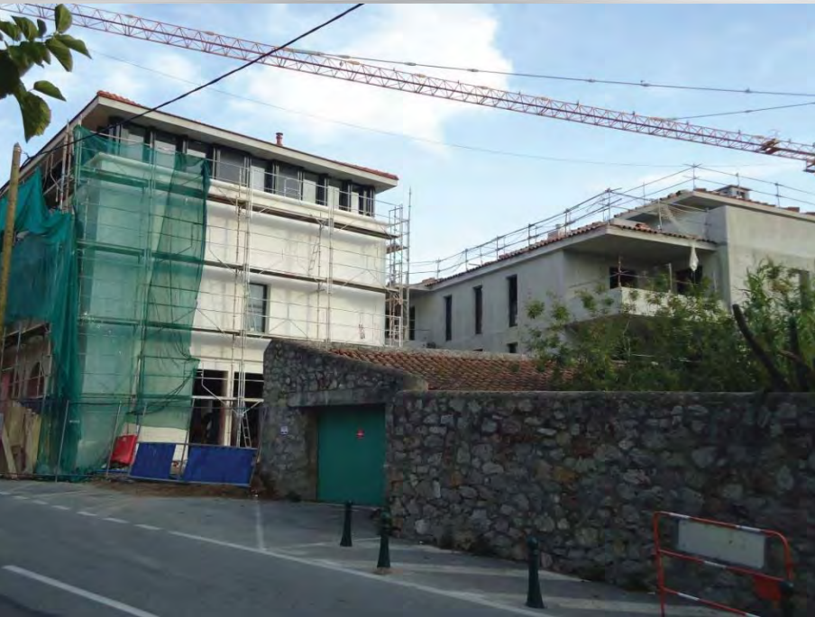
Bâtiments D et E logements sociaux
