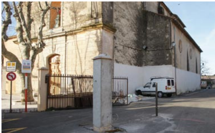
Travaux du portail du Couvent
