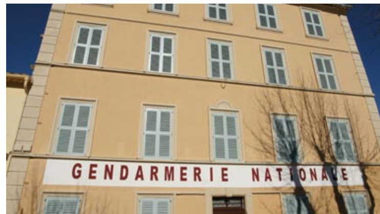
Réhabilitation de la facade de l'ex-gendarmerie
