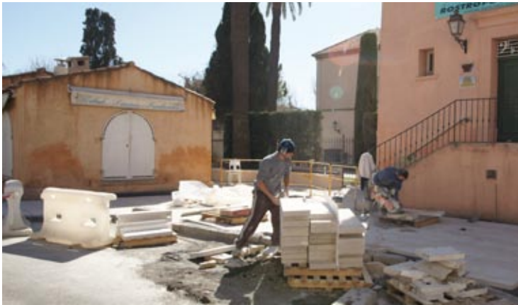
Travaux sur le petit marché place des Lices
