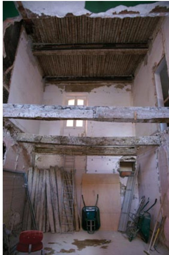
Travaux 1 rue de la Ponche
