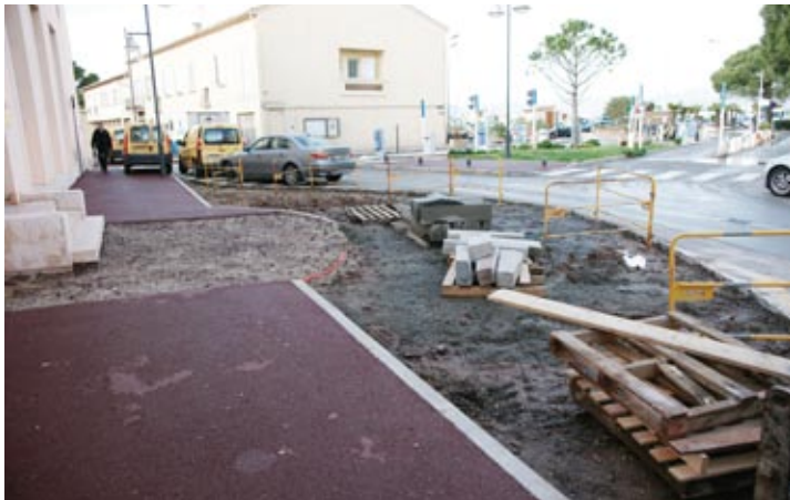
Travaux arrière La Poste
