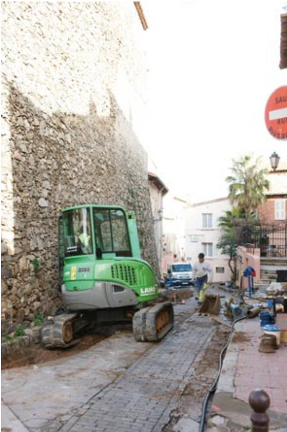
Travaux rue des Remparts
