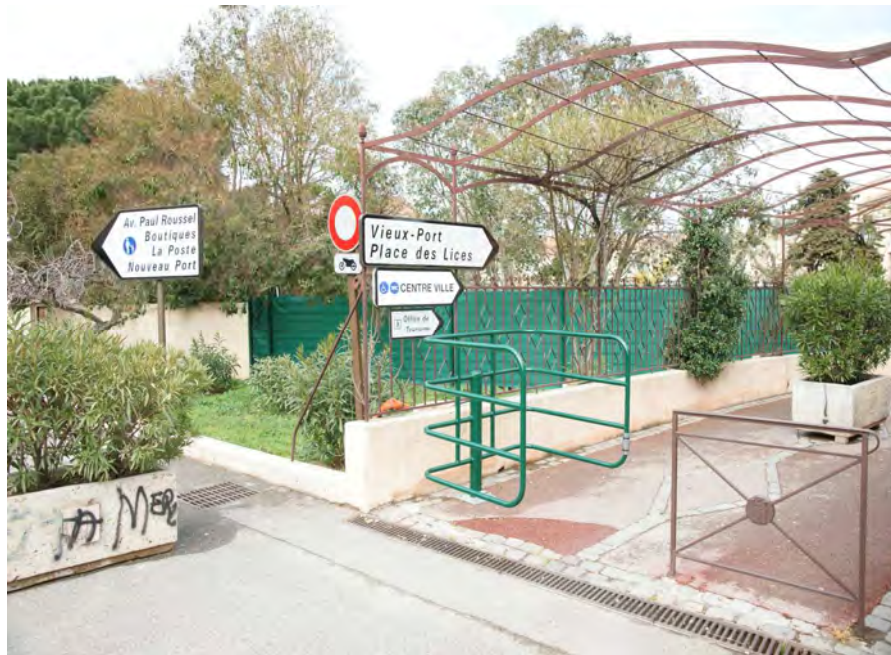
Pose de panneaux rue du Parc des Lices
