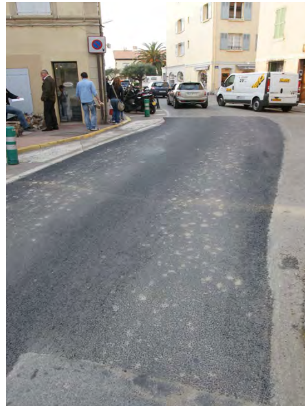
Reprise chaussée Traverse du Marbrier
