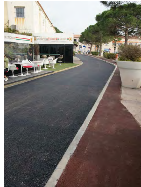
Réfection chaussée Quai de l'Epi
