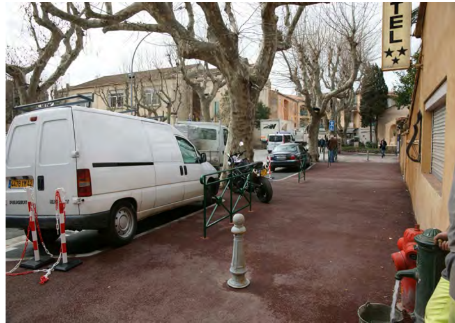
Aménagement trottoir Boulevard Vasserot
