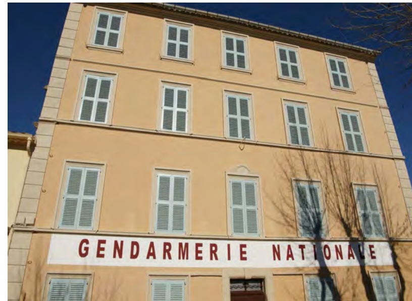
Réhabilitation de la façade de l'ancienne Gendarmerie
