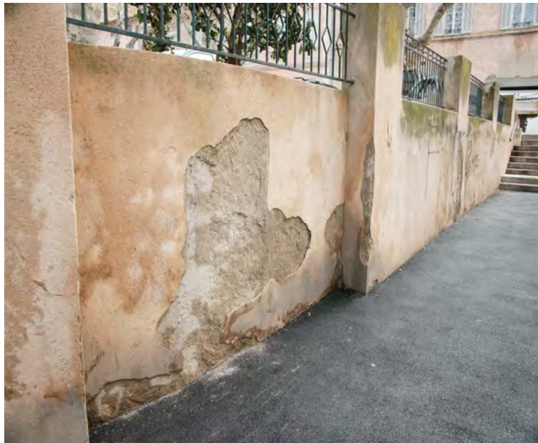
Revêtement venelle XVe Corps
