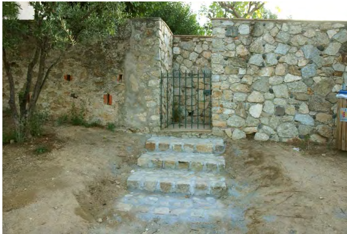
Travaux escalier achevés
