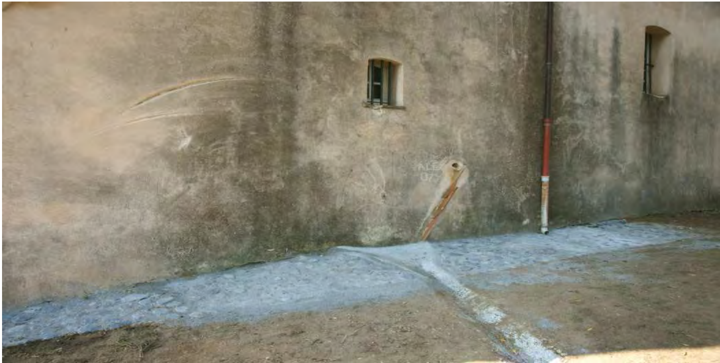
Étanchéité Chapelle Sainte-Anne
