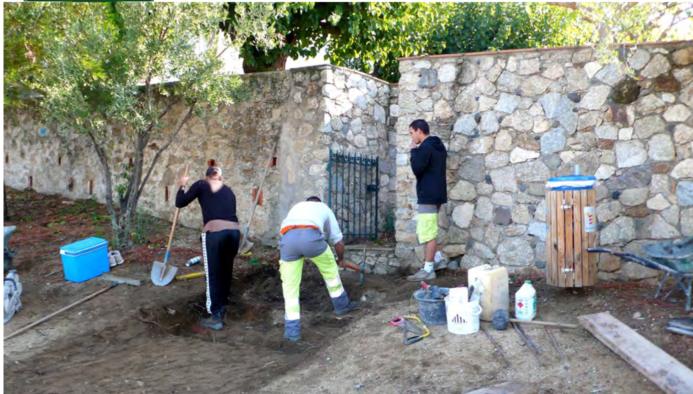
Travaux escaliers abords Chapelle Sainte-Anne
