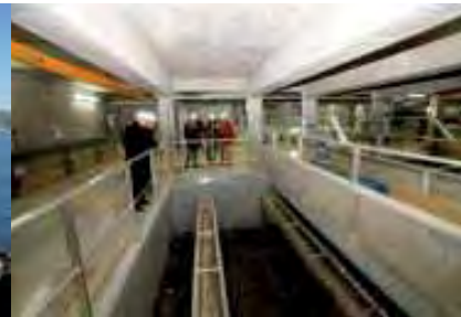
la station d'épuration
