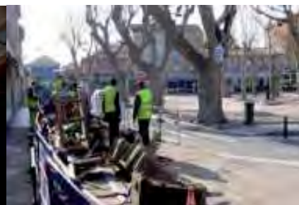
la réhabilitation des réseaux
