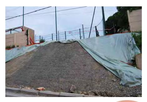
talus reprofilé et consolidé par les services technique grâce à la pose de protections
