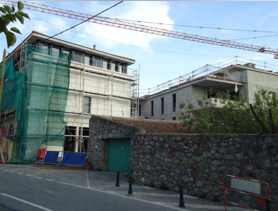
Bâtiments D et E logements sociaux
