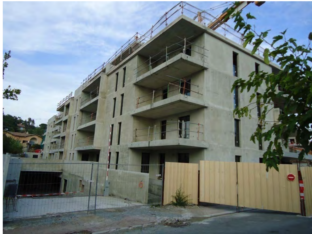
Entrée du parking sous-terrain public Bâtiment F Logements sociaux
