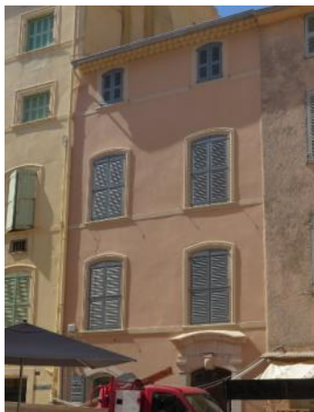
4, rue Cépoun San Martin : Façade 107
