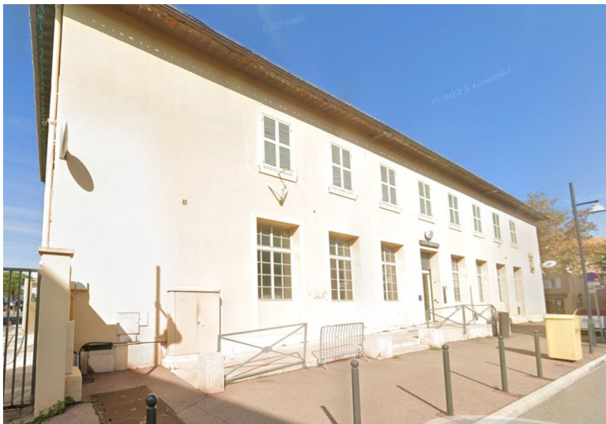
Vue sur le bâtiment de la Poste
