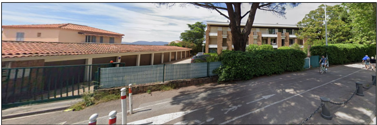
Le bâtiment « écran » au 92 av du Général Leclerc
