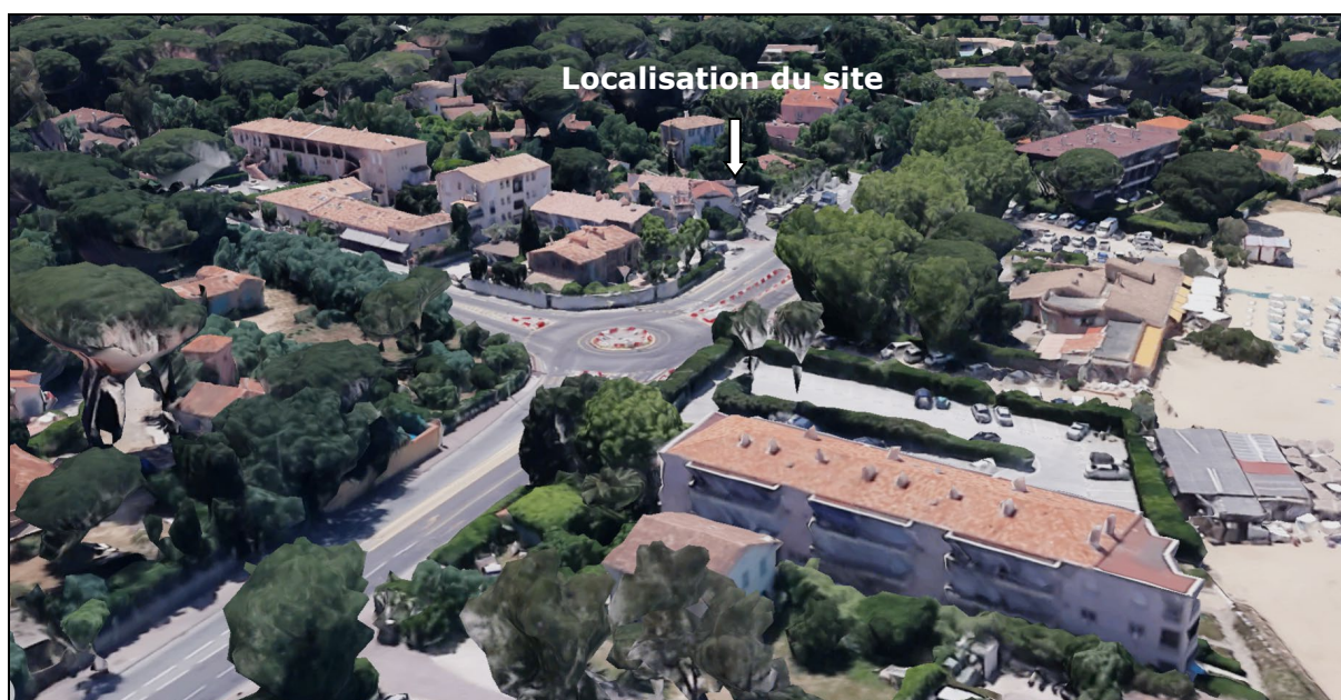
Les immeubles à proximité du site avec des hauteurs variant du R+2 au R+3
